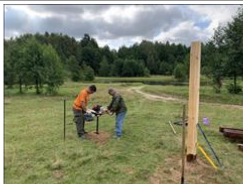
Стоянка Шурговаш Возведение стоянки Шурговаш. 56°46'0.45"С, 45°14'24.11"В Начало работ. 30.09.2020 г.
