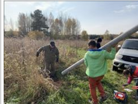
Установка столбов для туристской марки Установка асбоцементных столбов. 01-06.10.2020
