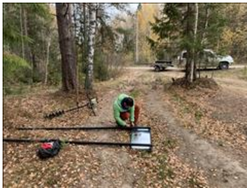
Установка информационных стендов и указателей Установка указателя на стоянку "Мериново". 19-27.10.2020
