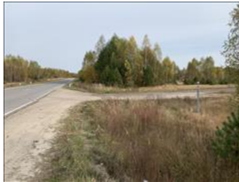
Установка столбов для туристской марки При отсутствии естественных объектов для нанесения туристской марки, на маршруте устанавливаются асбоцементные столбы. 01-06.10.2020
