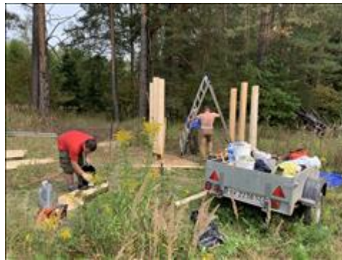
Стоянка Демьяновка Возведение стоянки Демьяновка. 56°48'38.98"С, 44°26'26.02"В Рабочий процесс 26.08.2020 г.
