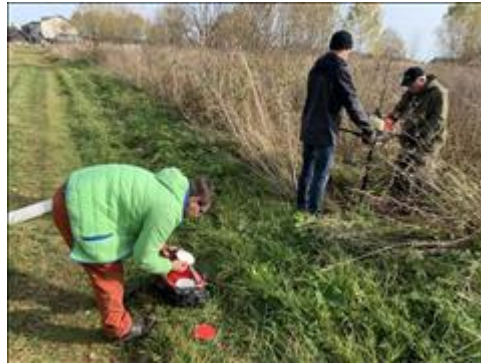
Установка столбов для туристской марки Параллельно с бурением скважины может наносится туристская марка на асбоцементный столб. 01-06.10.2020
