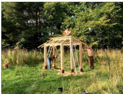
Стоянка Владимирское Возведение стоянки Владимирское. 56°48'33.12"С, 45° 6'24. 54"В Рабочий процесс. 29.09.2020 г.
