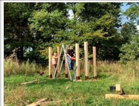
Стоянка Владимирское Возведение стоянки Владимирское. 56°48'33.12"С, 45° 6'24. 54"В Рабочий процесс. 29.09.2020 г.
