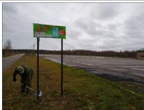
Установка информационных стендов и указателей Установка указателя на оз. Светлояр 19-27.10.2020
