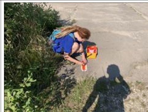
Маркировка маршрута Выполнение работ по нанесению туристской марки на маршруте. Асфальтовое покрытие на маршруте, как основа для нанесения марки. 28.07.-08.08.2020
