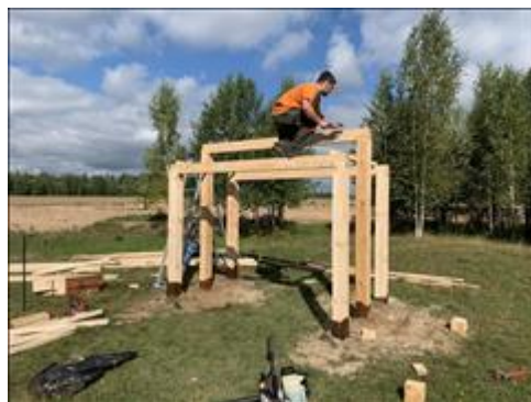
Стоянка Шурговаш Возведение стоянки Шурговаш. 56°46'0.45"С, 45°14'24.11"В Рабочий процесс. 30.09.2020 г.
