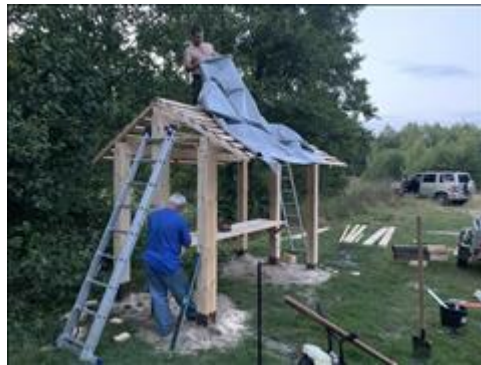
Стоянка Хохлома Возведение стоянки Хохлома. 56°58'25.04"С, 43°54'28.62"В Рабочий процесс. 01.09.2020 г.
