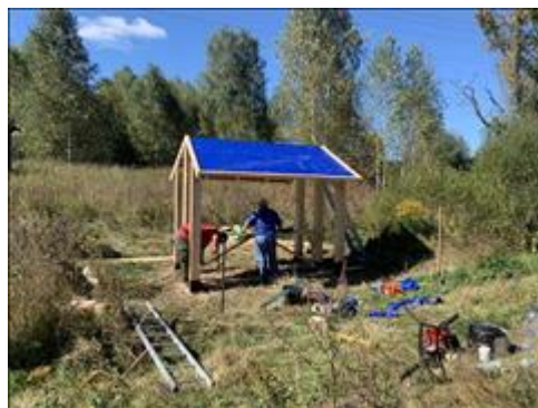
Стоянка Митюшино Возведение стоянки Митюшино. 56°53'27.42"С, 44°0'4.10"В Рабочий процесс 02.09.2020 г.
