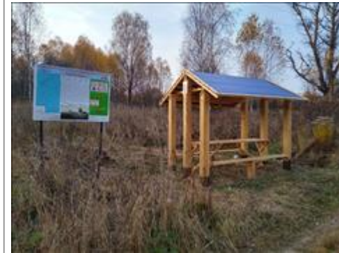
Установка информационных стендов и указателей Стоянка "Митюшино" и информационный стенд. 12-14.10.2020
