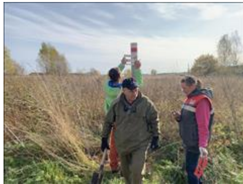
Установка столбов для туристской марки Установка асбоцементных столбов и нанесение на них туристской марки. 01-06.10.2020
