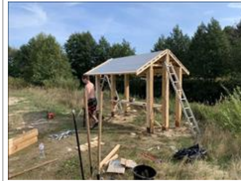
Стоянка Гари Возведение стоянки Гари. 57°3'40.90"С, 43°48'51.23"В Рабочий процесс. 31.08.2020 г.
