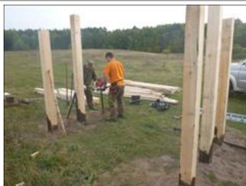
Стоянка в Ичалках Работы по обустройству стоянки в Ичалках
