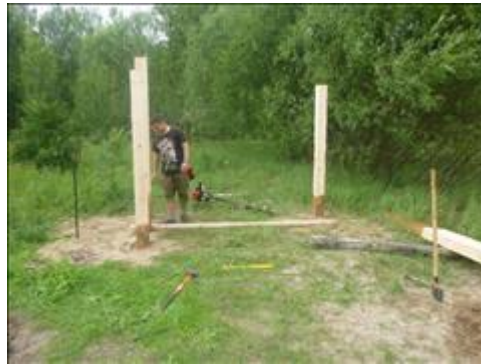
Стоянка в Никола-Ключ Работы по обустройству стоянки в Никола-Ключ
