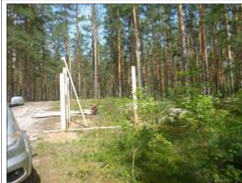
Стоянка на оз. Черносское Работы по обустройству стоянки на оз. Черносское
