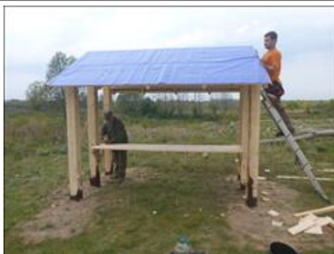
Стоянка в Ичалках Работы по обустройству стоянки в Ичалках
