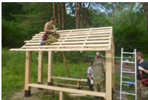
Строительство стоянок Строительство стоянки на Тосканских озерах 25.07.2018
