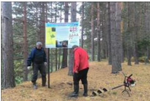
Установка информационных стендов и указателей Монтаж информационного стенда на водном маршруте по р. Керженец, тур стоянка Пенякша 20.09.2018
