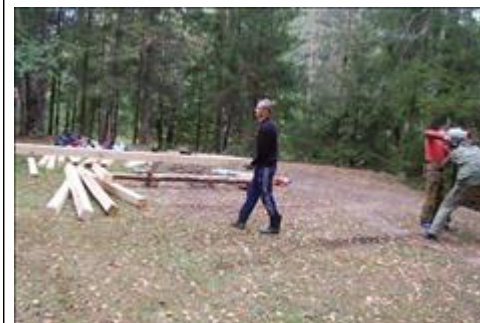
Строительство стоянок Строительство стоянки в Мариново 16.09.2018
