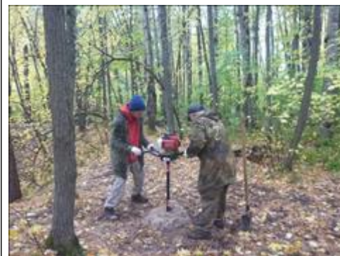
Установка информационных стендов и указателей Монтаж информационного стенда на водном маршруте по р. Пьяна, Ичалковский заказник, Старцев провал 25.09.2018
