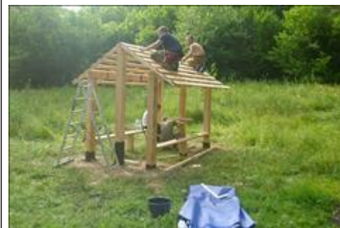
Строительство стоянок Строительство стоянки на Тосканских озерах 26.07.2018
