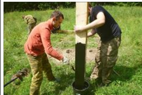
Строительство стоянок Строительство стоянки на Тосканских озерах 25.07.2018
