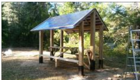
Строительство стоянок Строительство стоянки в Мериново 17.09.2018
