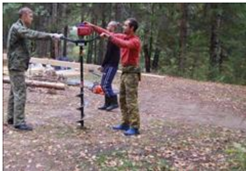
Строительство стоянок Строительство стоянки в Мериново 16.09.2018
