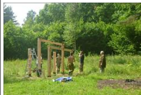
Строительство стоянок Строительство стоянки на Тосканских озерах 25.07.2018
