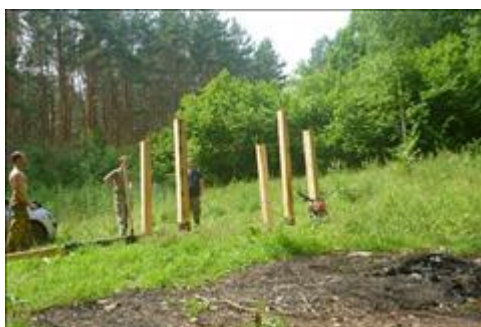
Строительство стоянок Строительство стоянки на Тосканских озерах 25.07.2018
