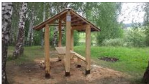
Тур стоянка "Березополье" Возведение тур стоянки "Березополье" недалеко от д. Ушаково 56° 8'56.27"С 43°20'59.14"В завершение работ 20.06.2018
