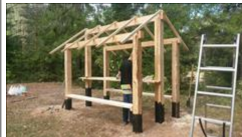
Строительство стоянок Строительство стоянки в Мериново 16.09.2018
