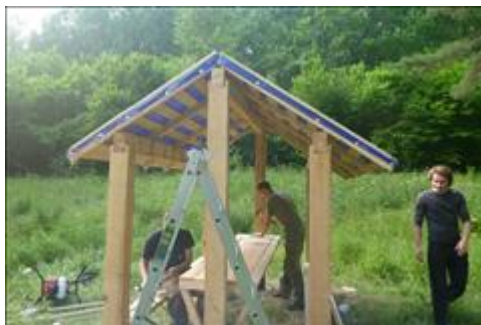
Строительство стоянок Строительство стоянки на Тосканских озерах 26.07.2018
